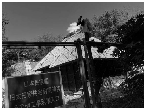
写真1：日本民家園での耐震補強工事の様子
