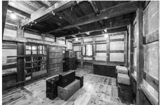
写真1：蔵の内部（現状）
