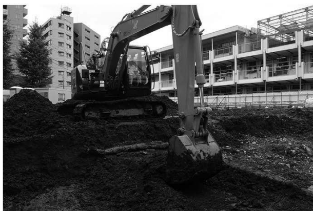
煉瓦等を取り外し、重機でさらに下を掘り下げる。
