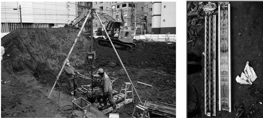
自然科学分析用にボーリングによる試料採取を行う。
