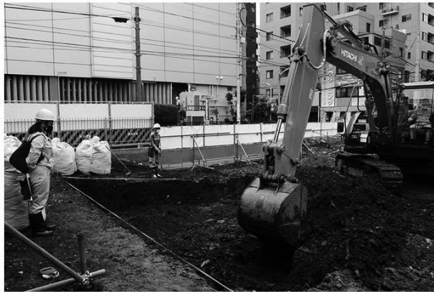
重機によって表土（現代の地面の土）を掘り下げる。
