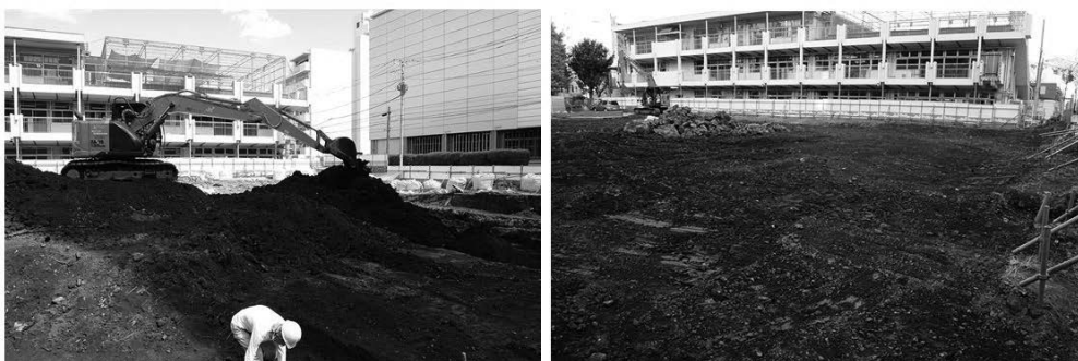
重機で埋め戻しと整地を行い、現場調査は終了。
