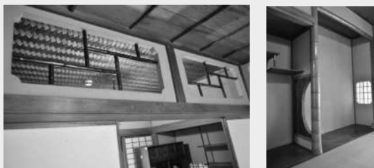
網代天井(茶室)、棹縁・欄間は煤竹(すすたけ) 床柱は京銘竹?
