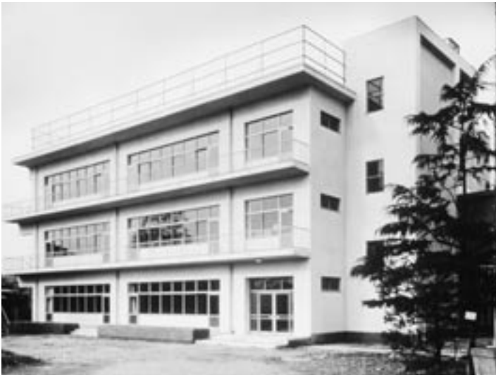
昭和三十一年三月完成した二号館
