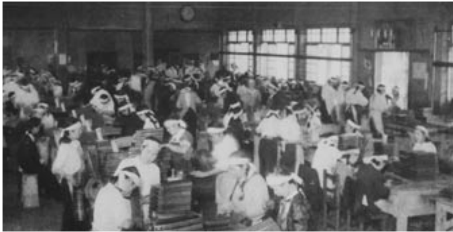
理研王子鋼材跡見工場での作業。生徒たちは機関砲の弾倉の製作に従事している。
